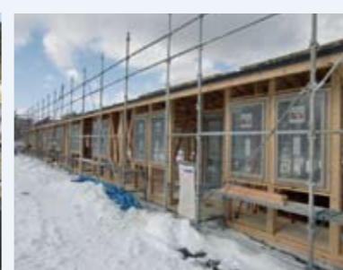
建設中の仮設店舗街 (女川町)
